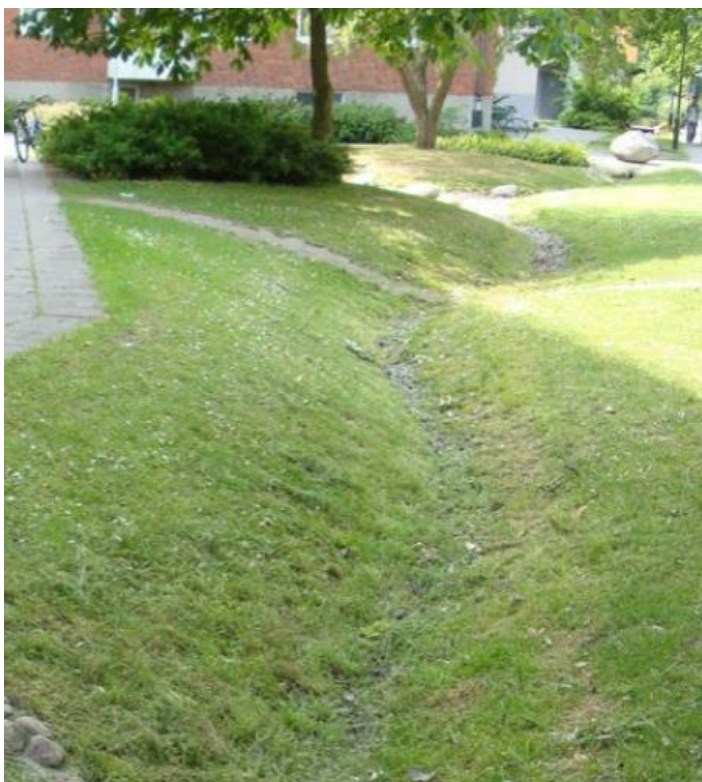
Figur 19. Svackdike (Foto: Sweco)
