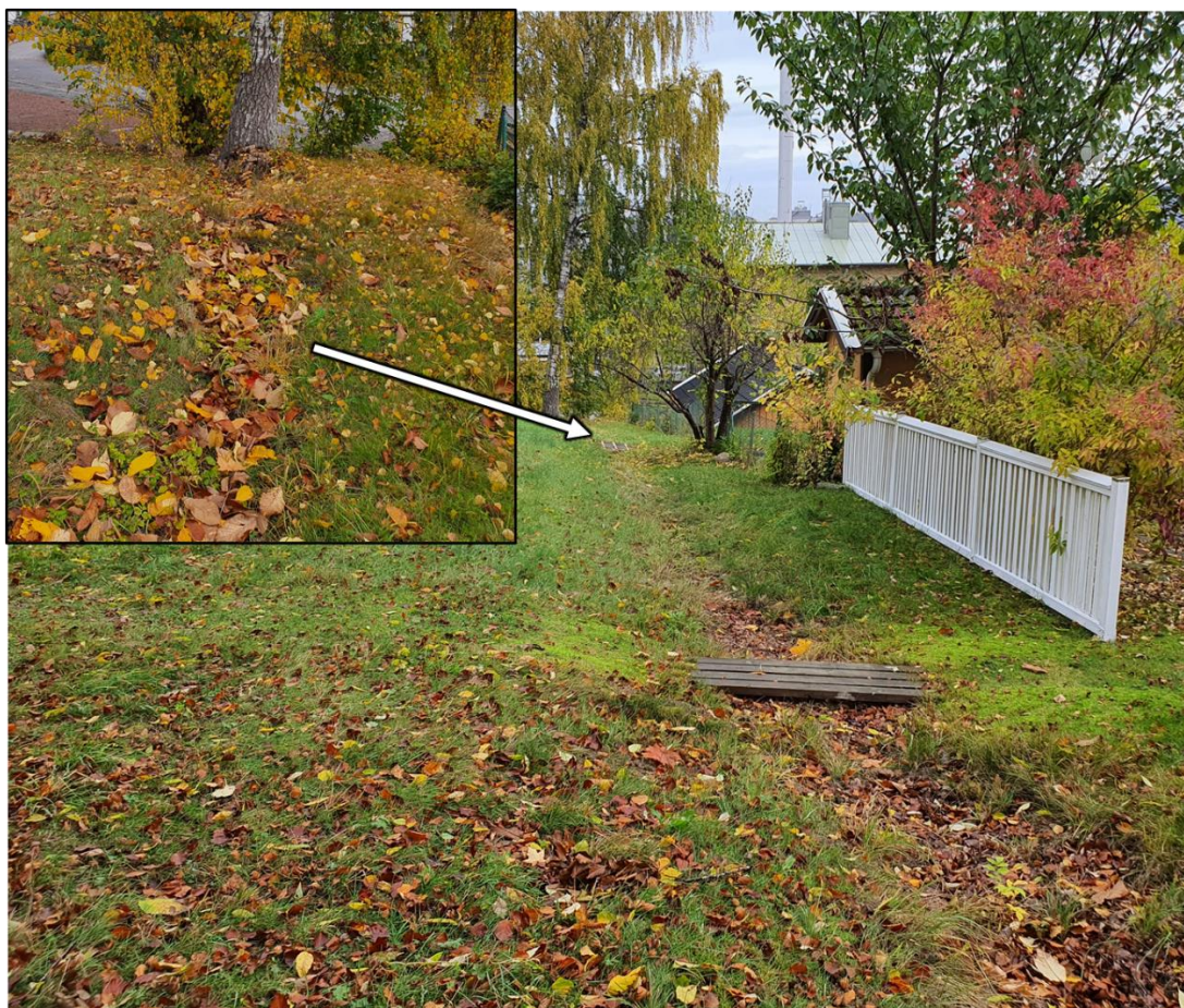
Figur 8. Dike 2 utmed planområdets östra gräns. Inklippt bild visar begränsad kapacitet i nedströms del av diket (Foto: SBK).
